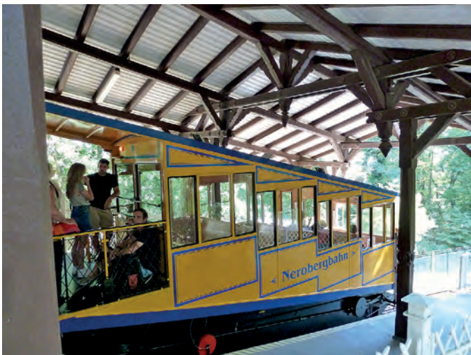
An der Talstation (oberes Bild) hat sich rein äußerlich ebenso wie bei der Bergstation (Mitte und unten) über 135 Jahre kaum etwas verändert.
